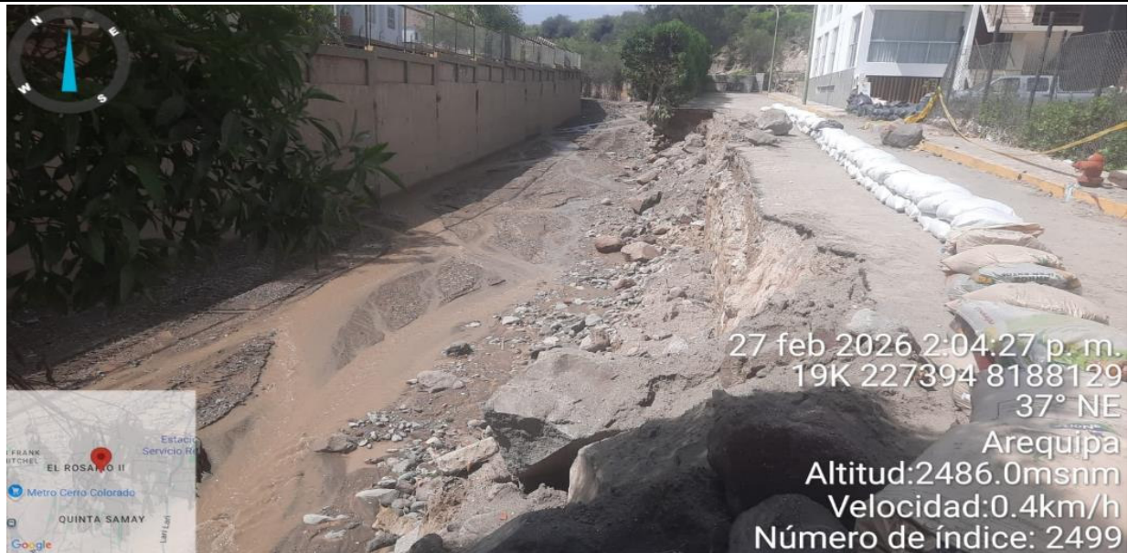
IMAGEN 01: SE OBSERVA LOS DAÑOS QUE HA OCASIONADO LA CRECIDA DE LA QUEBRADA CHULLO, SOCAVANDO SU MARGEN IZQUIERDA, AFECTANDO A LAS
