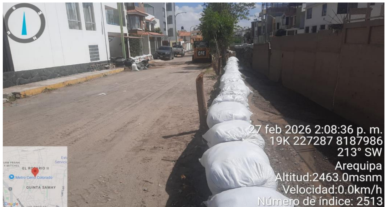
IMAGEN 02: EN ESTE TRAMO SE OBSERVA LA COLOCACION DE SACOS CON ARENA EN LA MARGEN IZQUIERDA, OCASIONADA POR LA CRECIDA DE LA
