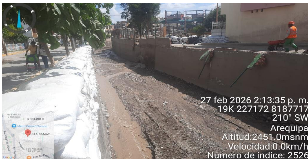
IMAGEN 02: EN ESTE TRAMO SE OBSERVA LA COLOCACIÓN DE SACOS EN LA MARGEN IZQUIERDA, OCASIONADA POR LA CRECIDA DE LA QUEBRADA CHULLO,
